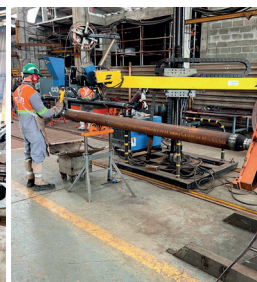
Solda por arco submerso.
