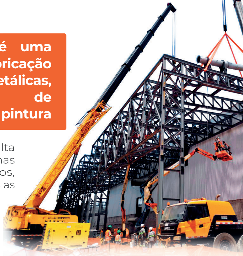
Engenharia, fabricação e montagem das estruturas e dutos.
