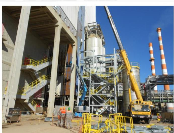
Montagem eletromecânica de cristalizador e ETE lodo ativado.
