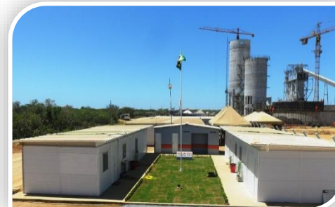
Canteiro de Obra
